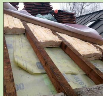
Le toit de la caserne des pompiers a été rénové et isolé en février 2015. Depuis, la **consommation de chauffage** dans ce bâtiment a nettement diminué. La consommation de chauffage est passée de 31'270 kWh en 2015 à 21'322 en 2018, ce qui représente une **diminution de 31,81%**. 872,63 m<sup>3</sup> de gaz et de 2'269 kg de CO<sup>2</sup> ont pu être économisés.
