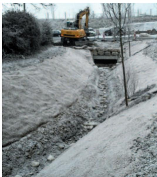
*L'arrivée de l'ouvrage pour le passage du cours d'eau sous la route de Vireloup*
